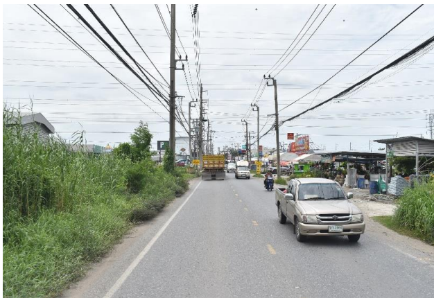
รูปก่อนการก่อสร้าง กม.ที่ ๖+๓๐๐
