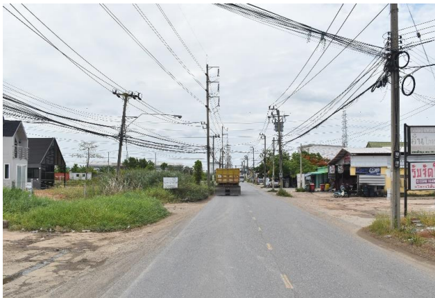
รูปก่อนการก่อสร้าง กม.ที่ ๖+๑๐๐
