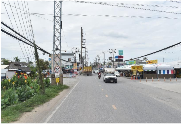
รูปก่อนการก่อสร้าง กม.ที่ ๖+๔๐๐
