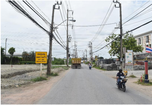
รูปก่อนการก่อสร้าง กม.ที่ ๖+๒๐๐
