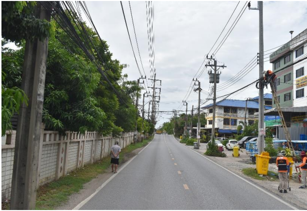
รูปก่อนการก่อสร้าง กม.ที่ ๗+๐๐๐
