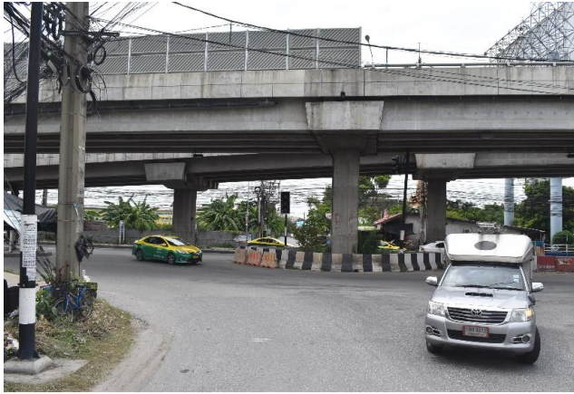
รูปก่อนการก่อสร้าง กม.ที่ ๘+๑๙๒ (จุดสิ้นสุดโครงการ)
