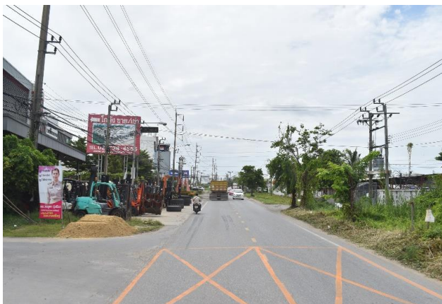
รูปก่อนการก่อสร้าง กม.ที่ ๕+๙๐๐
