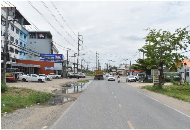
รูปก่อนการก่อสร้าง กม.ที่ ๖+๐๐๐
