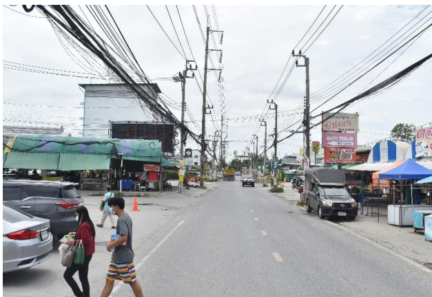
รูปก่อนการก่อสร้าง กม.ที่ ๖+๕๐๐
