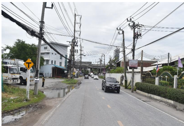
รูปก่อนการก่อสร้าง กม.ที่ ๘+๑๐๐
