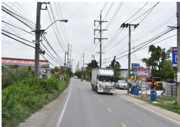
รูปก่อนการก่อสร้าง กม.ที่ ๔+๑๐๐
