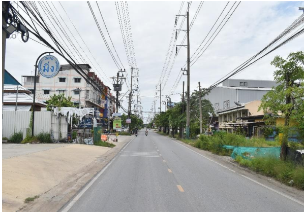
รูปก่อนการก่อสร้าง กม.ที่ ๓+๒๐๐
