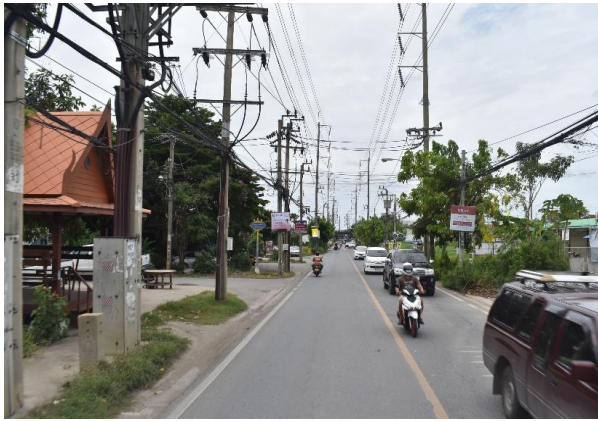
รูปก่อนการก่อสร้าง กม.ที่ ๒+๒๐๐
