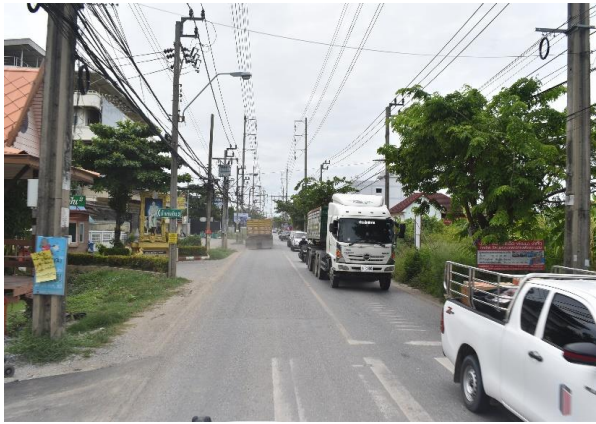
รูปก่อนการก่อสร้าง กม.ที่ ๔+๖๐๐
