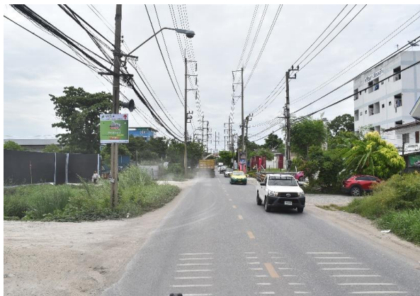
รูปก่อนการก่อสร้าง กม.ที่ ๔+๗๐๐
