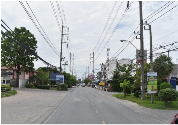
รูปก่อนการก่อสร้าง กม.ที่ ๐+๖๐๐
