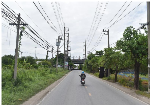
รูปก่อนการก่อสร้าง กม.ที่ ๓+๗๐๐
