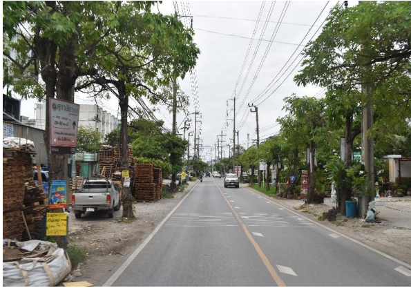
รูปก่อนการก่อสร้าง กม.ที่ ๒+๘๐๐
