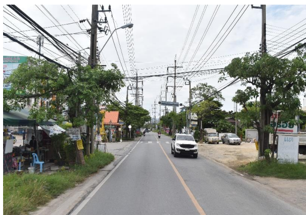
รูปก่อนการก่อสร้าง กม.ที่ ๒+๙๐๐
