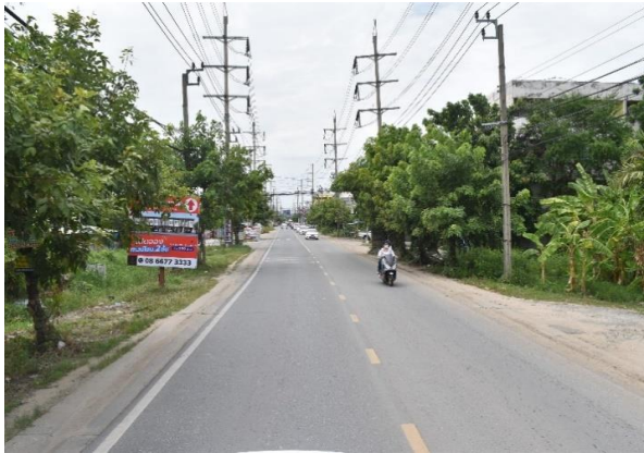
รูปก่อนการก่อสร้าง กม.ที่ ๐+๒๐๐
