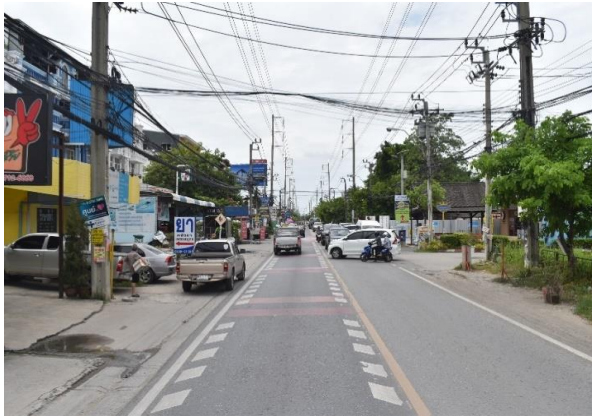
รูปก่อนการก่อสร้าง กม.ที่ ๑+๒๐๐
