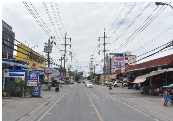
รูปก่อนการก่อสร้าง กม.ที่ ๐+๙๐๐
