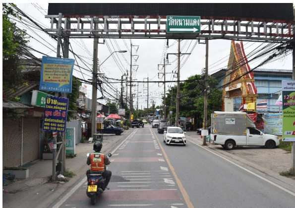
รูปก่อนการก่อสร้าง กม.ที่ ๒+๕๐๐
