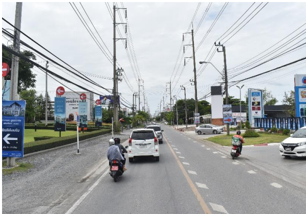
รูปก่อนการก่อสร้าง กม.ที่ ๑+๔๐๐
