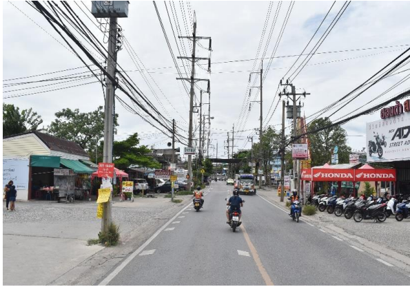
รูปก่อนการก่อสร้าง กม.ที่ ๒+๔๐๐
