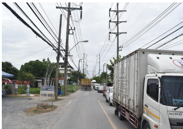
รูปก่อนการก่อสร้าง กม.ที่ ๔+๕๐๐
