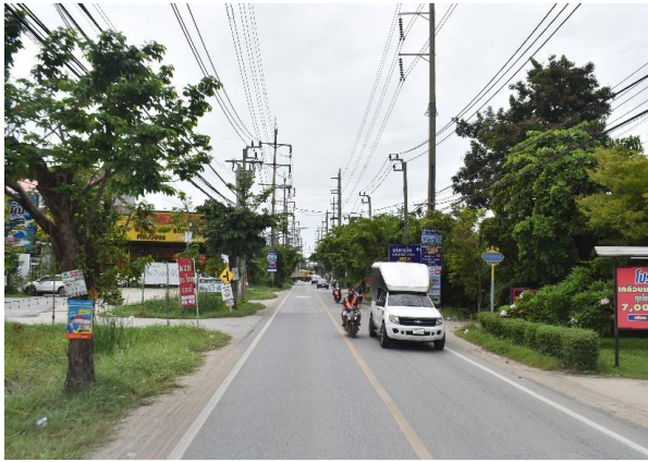
รูปก่อนการก่อสร้าง กม.ที่ ๔+๒๐๐
