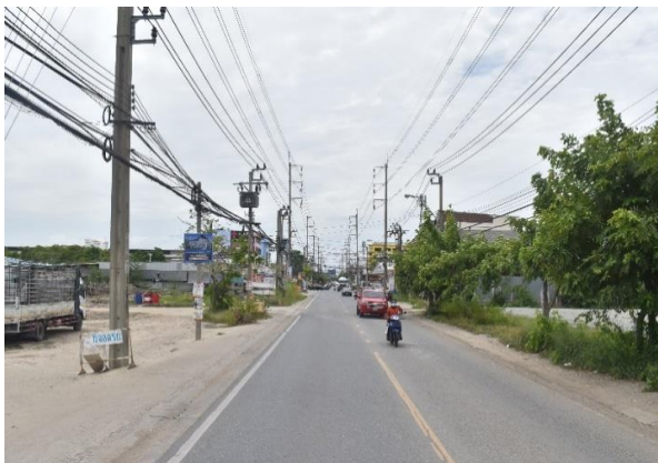
รูปก่อนการก่อสร้าง กม.ที่ ๐+๓๐๐
