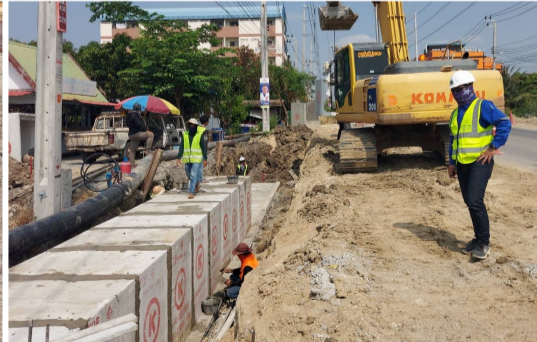
งานท่อเหลี่ยมคอนกรีตเสริมเหล็กขนาด 1 - 1.20 x 1.20 เมตร กม.ที่ 5+050 - กม.ที่ 5+950 LT และกม.ที่ 3+445 - กม.ที่ 3+474 RT
