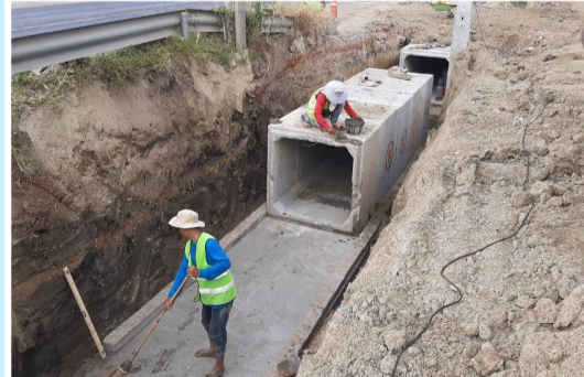
งานท่อเหลี่ยมคอนกรีตเสริมเหล็กขนาด 1 - 1.20 x 1.20 เมตร กม.ที่ 5+050 - กม.ที่ 5+950 LT และกม.ที่ 3+445 - กม.ที่ 3+474 RT
