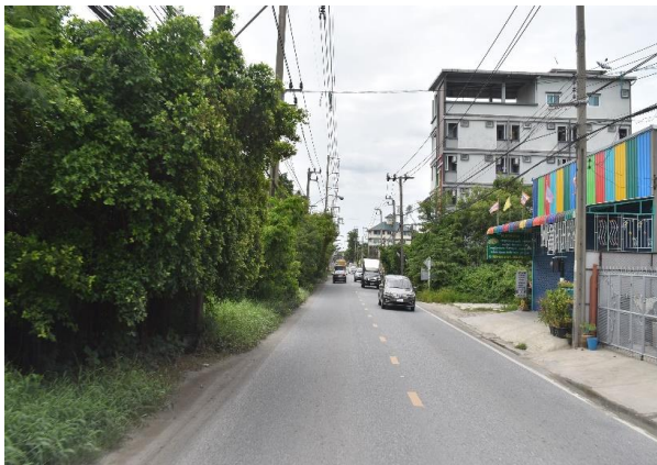
รูปก่อนการก่อสร้าง กม.ที่ ๗+๙๐๐
