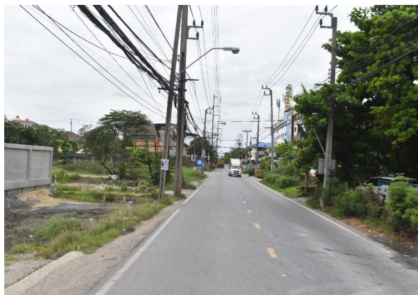
รูปก่อนการก่อสร้าง กม.ที่ ๖+๙๐๐
