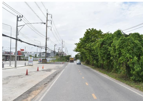
รูปก่อนการก่อสร้าง กม.ที่ ๕+๗๐๐
