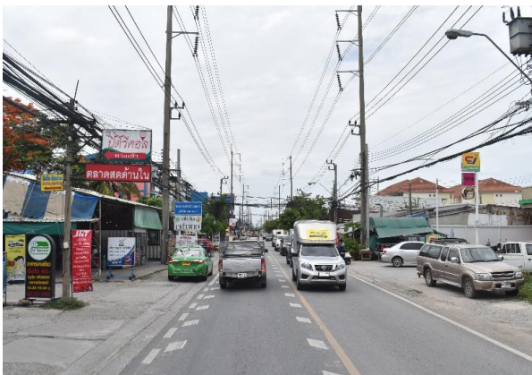
รูปก่อนการก่อสร้าง กม.ที่ ๑+๑๐๐
