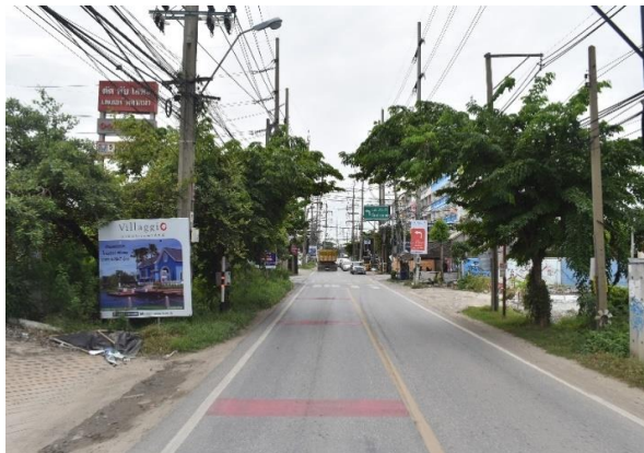
รูปก่อนการก่อสร้าง กม.ที่ ๔+๓๐๐
