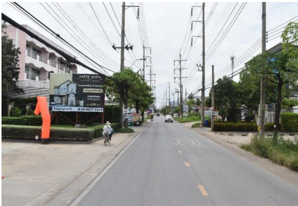
รูปก่อนการก่อสร้าง กม.ที่ ๓+๐๐๐
