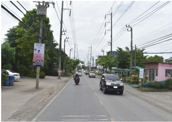
รูปก่อนการก่อสร้าง กม.ที่ ๑+๘๐๐
