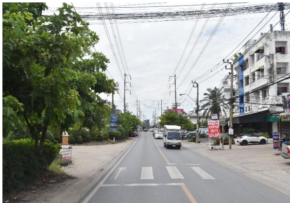
รูปก่อนการก่อสร้าง กม.ที่ ๐+๗๐๐
