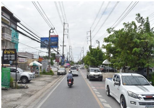
รูปก่อนการก่อสร้าง กม.ที่ ๑+๓๐๐
