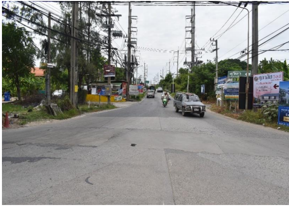
รูปก่อนการก่อสร้าง กม.ที่ ๐+๐๐๐ (จุดเริ่มต้นโครงการ)
