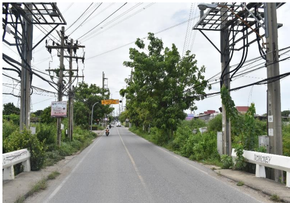
รูปก่อนการก่อสร้าง กม.ที่ ๒+๑๐๐
