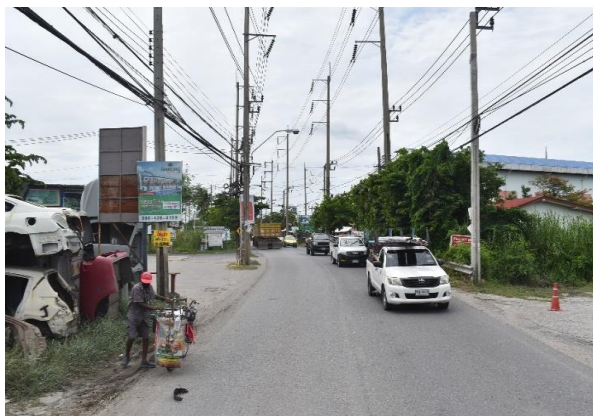
รูปก่อนการก่อสร้าง กม.ที่ ๕+๑๐๐
