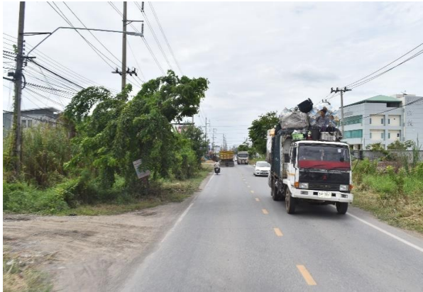
รูปก่อนการก่อสร้าง กม.ที่ ๕+๘๐๐
