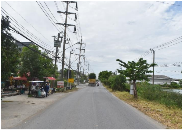
รูปก่อนการก่อสร้าง กม.ที่ ๕+๔๐๐
