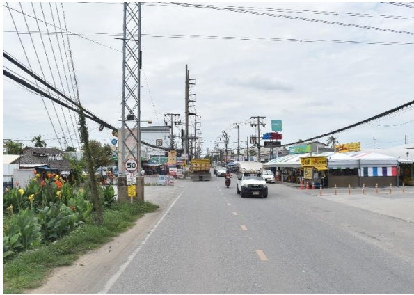
รูปก่อนการก่อสร้าง กม.ที่ ๖+๔๐๐
