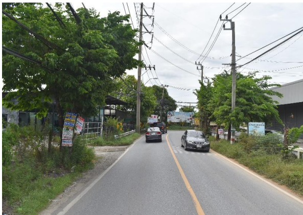
รูปก่อนการก่อสร้าง กม.ที่ ๗+๕๐๐
