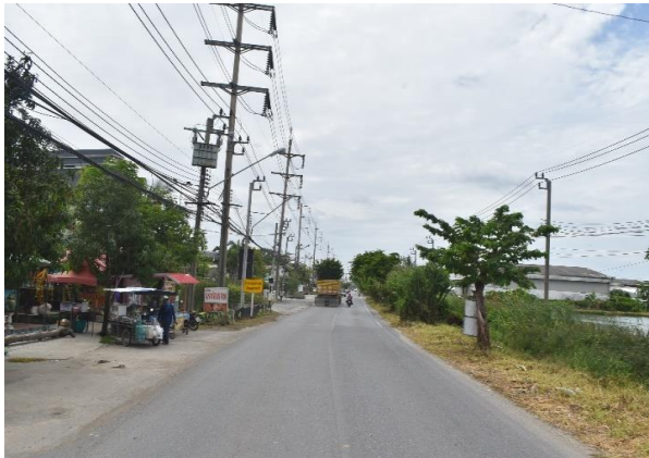
รูปก่อนการก่อสร้าง กม.ที่ ๔+๐๐
