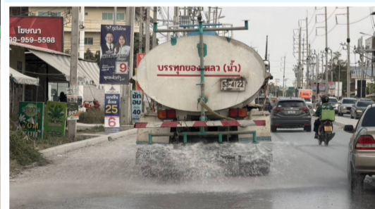
งานควบคุมและป้องกันมลภาวะ ในการก่อสร้าง กม.ที่ 0+000 - 8+192 LT, RT
