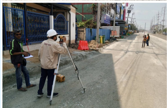
งานรองพื้นทางหินคลุก และงานพื้นทางหินคลุก กม.ที่ 6+850 - กม.ที่ 8+070 LT, RT
