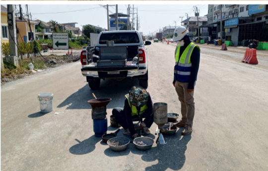
งานรองพื้นทางหินคลุก และงานพื้นทางหินคลุก กม.ที่ 6+850 - กม.ที่ 8+070 LT, RT
