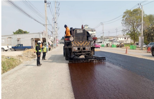
งานลาดแอสฟัลต์ PRIME COAT และงานปูผิวทางแอสฟัลต์คอนกรีตชั้น BINDER COURSE กม.ที่ 6+850 - กม.ที่ 8+070 LT,RT
