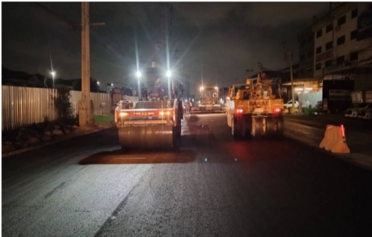
งานลาดแอสฟัลต์ PRIME COAT และงานปูผิวทางแอสฟัลต์คอนกรีตชั้น BINDER COURSE กม.ที่ 6+850 - กม.ที่ 8+070 LT,RT
