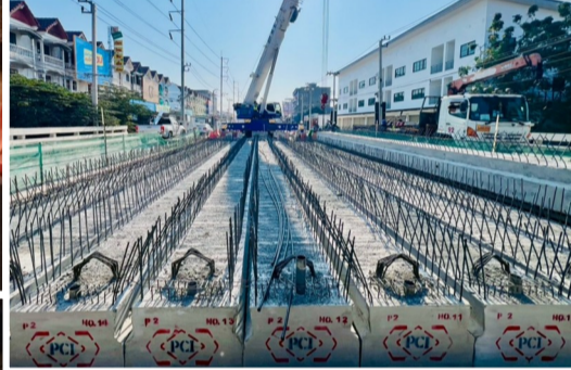
งานวาง Box Girder กม.ที่ 0+828.364 (สะพานคลองหนามแดงเดชะ) กม.ที่ 2+692.197 (สะพานคลองหลวงแพ่ง) และกม.ที่ 3+417.290 (สะพานคลองตัน)
