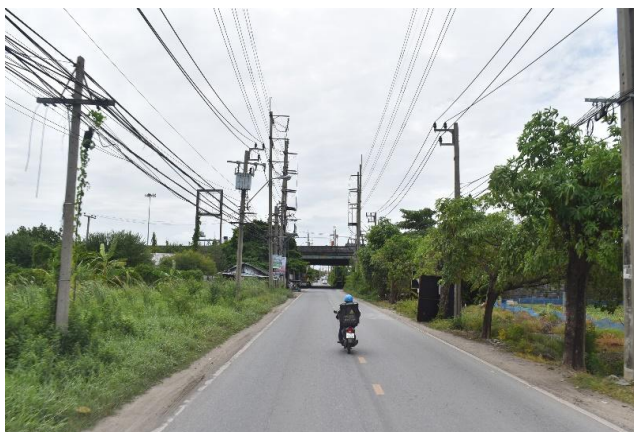
รูปก่อนการก่อสร้าง กม.ที่ ๓+๗๐๐
