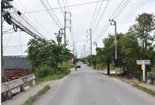
รูปก่อนการก่อสร้าง กม.ที่ ๓+๔๐๐
