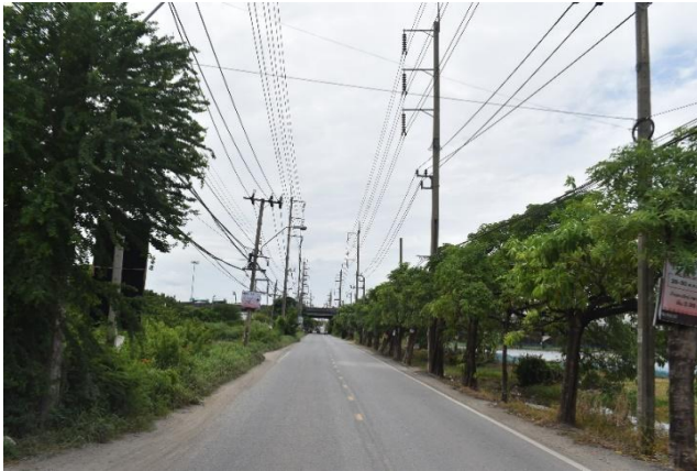
รูปก่อนการก่อสร้าง กม.ที่ ๓+๖๐๐
