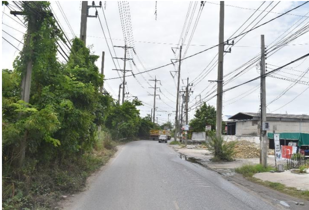
รูปก่อนการก่อสร้าง กม.ที่ ๕+๐๐๐
