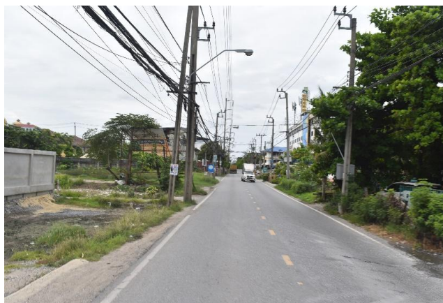
รูปก่อนการก่อสร้าง กม.ที่ ๖+๙๐๐
