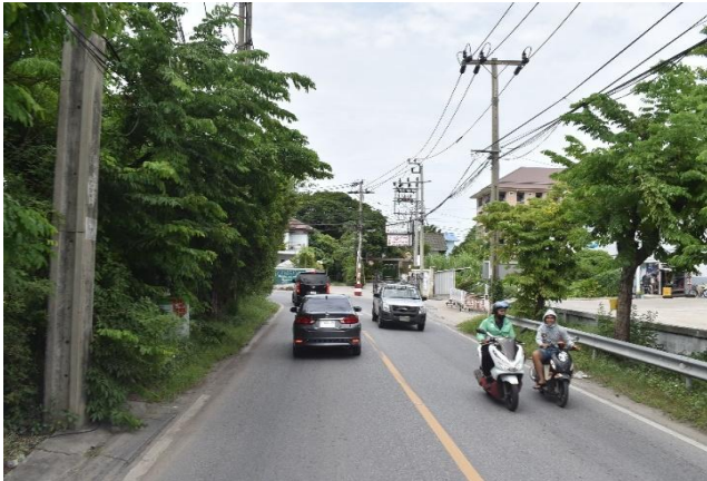
รูปก่อนการก่อสร้าง กม.ที่ ๗+๖๐๐
