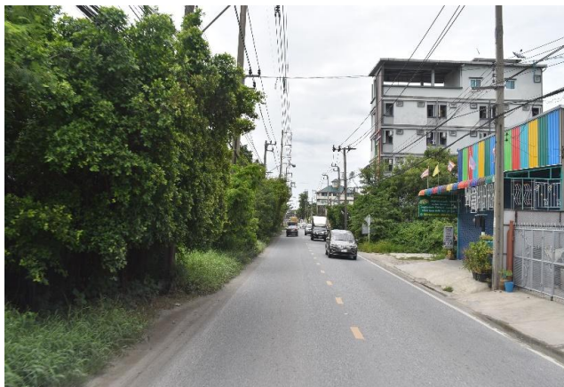
รูปก่อนการก่อสร้าง กม.ที่ ๗+๙๐๐
