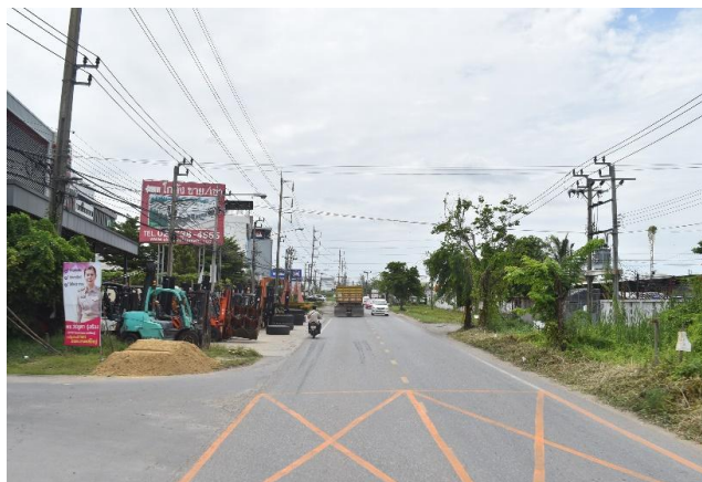
รูปก่อนการก่อสร้าง กม.ที่ ๕+๙๐๐
