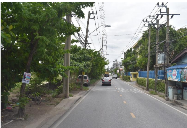
รูปก่อนการก่อสร้าง กม.ที่ ๗+๗๐๐
