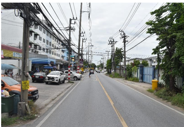
รูปก่อนการก่อสร้าง กม.ที่ ๗+๓๐๐
