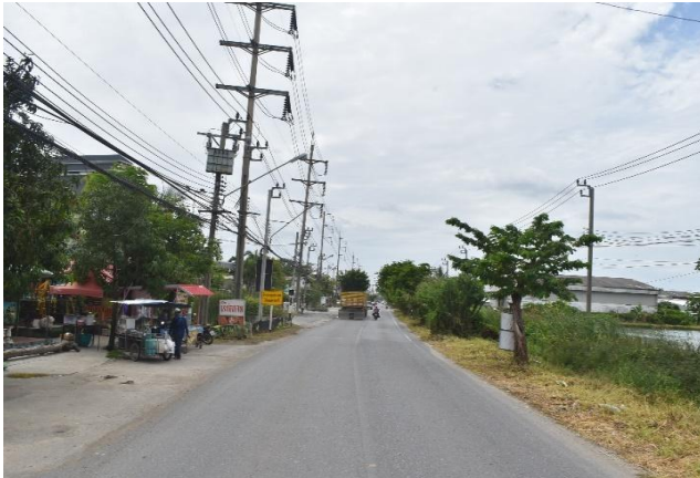
รูปก่อนการก่อสร้าง กม.ที่ ๕+๔๐๐
