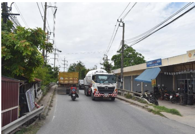
รูปก่อนการก่อสร้าง กม.ที่ ๕+๓๐๐
