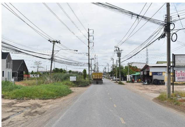
รูปก่อนการก่อสร้าง กม.ที่ ๖+๑๐๐
