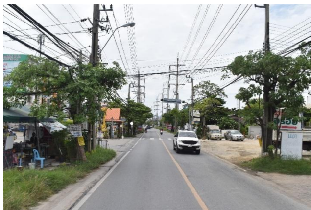
รูปก่อนการก่อสร้าง กม.ที่ ๒+๙๐๐
