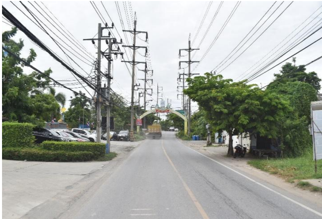
รูปก่อนการก่อสร้าง กม.ที่ ๔+๘๐๐
