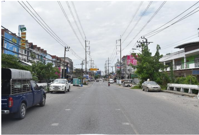
รูปก่อนการก่อสร้าง กม.ที่ ๐+๘๐๐
