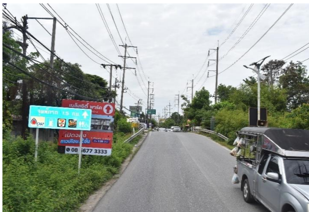
รูปก่อนการก่อสร้าง กม.ที่ ๐+๑๐๐
