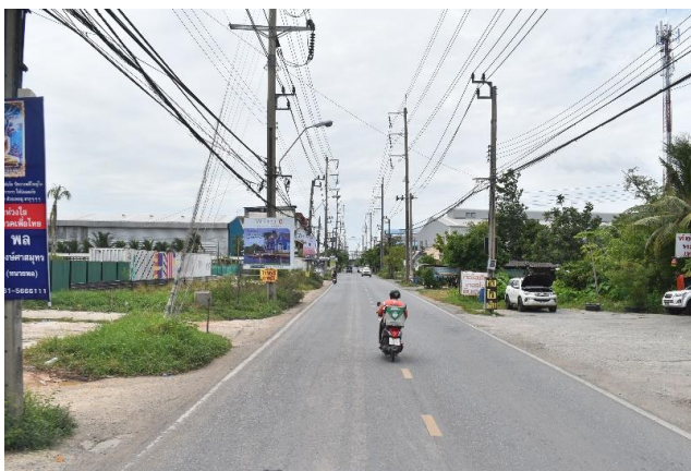
รูปก่อนการก่อสร้าง กม.ที่ ๓+๑๐๐
