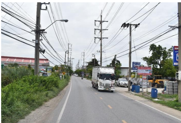
รูปก่อนการก่อสร้าง กม.ที่ ๔+๑๐๐
