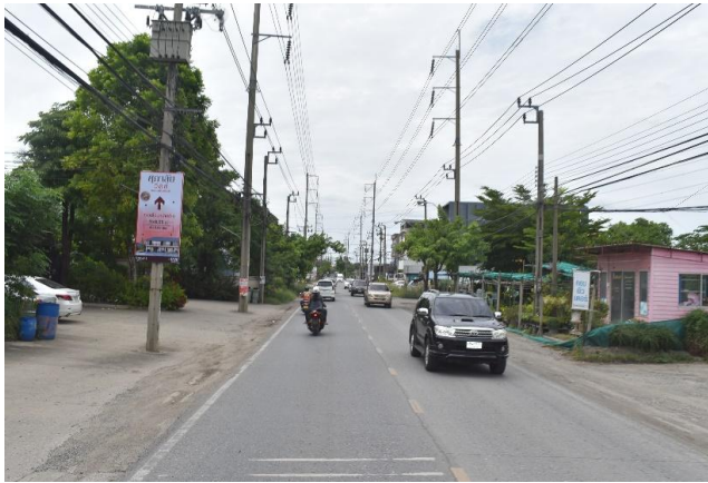
รูปก่อนการก่อสร้าง กม.ที่ ๑+๘๐๐
