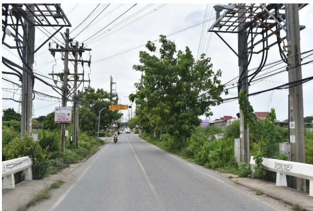
รูปก่อนการก่อสร้าง กม.ที่ ๒+๑๐๐
