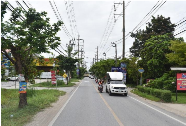
รูปก่อนการก่อสร้าง กม.ที่ ๔+๒๐๐
