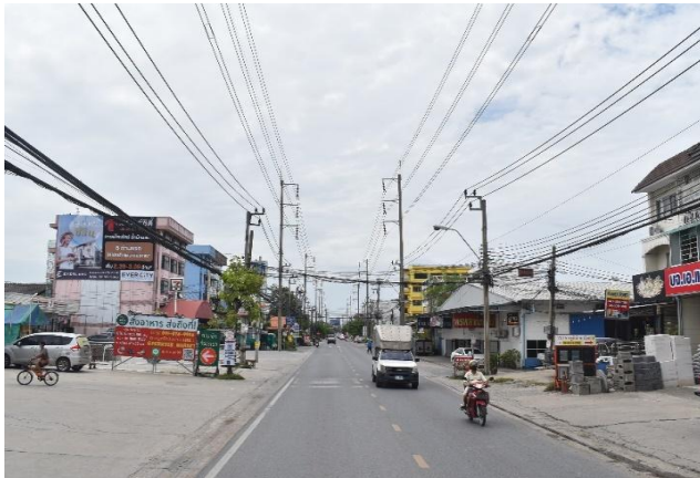
รูปก่อนการก่อสร้าง กม.ที่ ๐+๔๐๐
