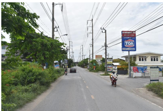
รูปก่อนการก่อสร้าง กม.ที่ ๓+๕๐๐
