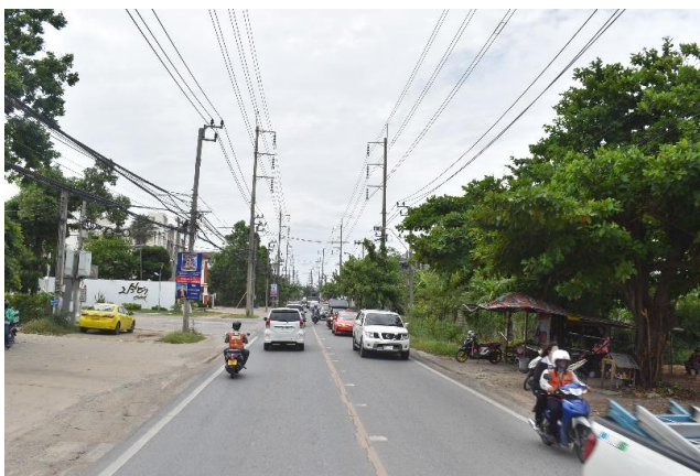
รูปก่อนการก่อสร้าง กม.ที่ ๑+๗๐๐
