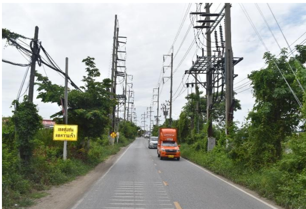
รูปก่อนการก่อสร้าง กม.ที่ ๓+๙๐๐
