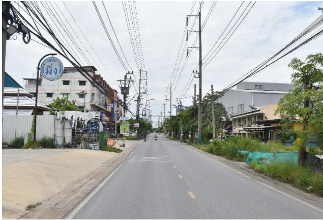
รูปก่อนการก่อสร้าง กม.ที่ ๓+๒๐๐
