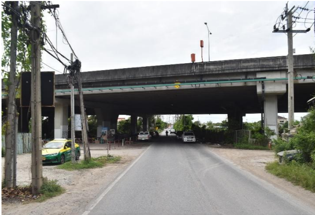
รูปก่อนการก่อสร้าง กม.ที่ ๓+๘๐๐
