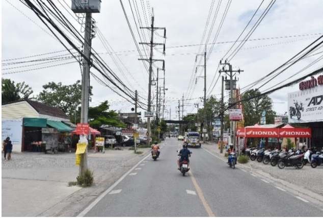
รูปก่อนการก่อสร้าง กม.ที่ ๒+๔๐๐
