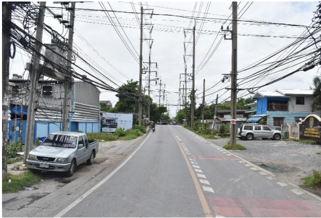
รูปก่อนการก่อสร้าง กม.ที่ ๒+๖๐๐
