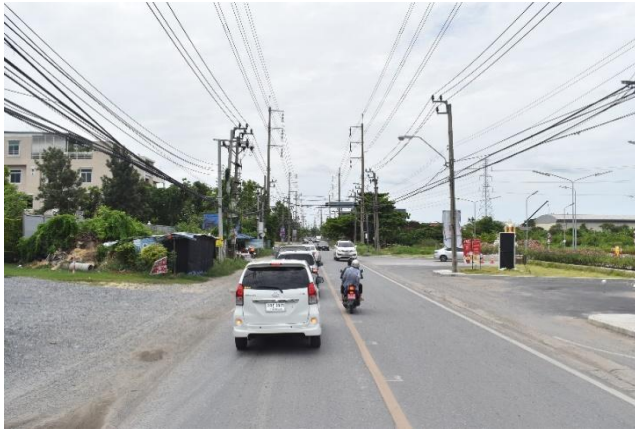
รูปก่อนการก่อสร้าง กม.ที่ ๑+๖๐๐
