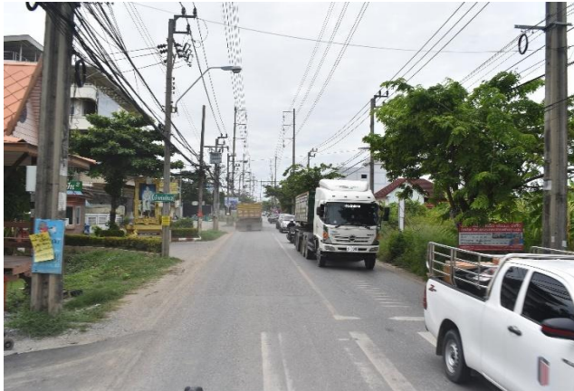
รูปก่อนการก่อสร้าง กม.ที่ ๔+๖๐๐
