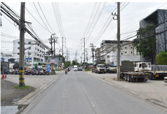
รูปก่อนการก่อสร้าง กม.ที่ ๑+๙๐๐
