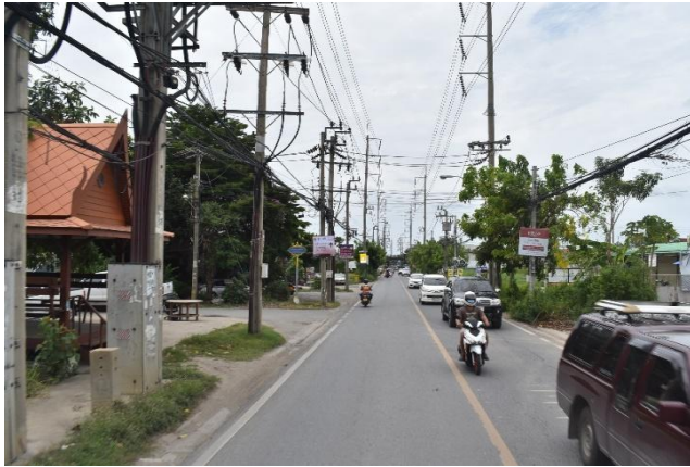
รูปก่อนการก่อสร้าง กม.ที่ ๒+๒๐๐
