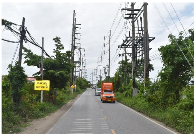
รูปก่อนการก่อสร้าง กม.ที่ ๓+๙๐๐
