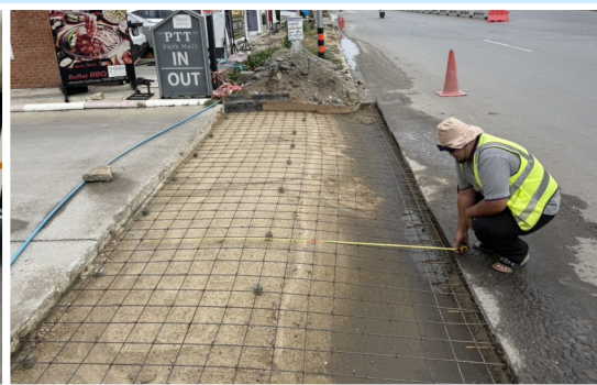
งานพื้นคอนกรีตปรับระดับช่วงเข้าสู่สะพาน (BRIDGE APPROACH SLAB) กม.ที่ 2+117.888 (สะพานคลองปลัดเปรียง)
