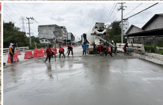
งานพื้นคอนกรีตปรับระดับช่วงเข้าสู่สะพาน (BRIDGE APPROACH SLAB) กม.ที่ 2+117.888 (สะพานคลองปลัดเปรียง)
