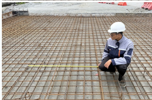
งานพื้นคอนกรีตปรับระดับช่วงเข้าสู่สะพาน (BRIDGE APPROACH SLAB) กม.ที่ 2+117.888 (สะพานคลองปลัดเปรียง)
