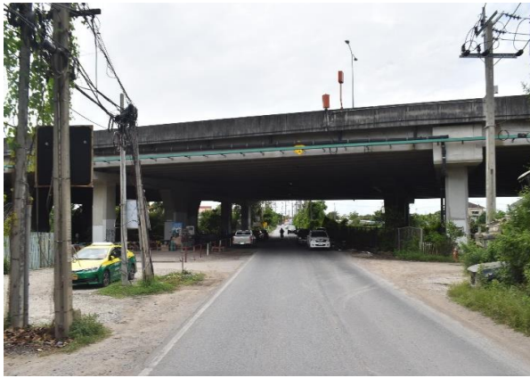
รูปก่อนการก่อสร้าง กม.ที่ ๓+๘๐๐
