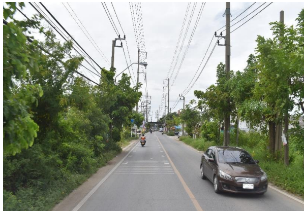
รูปก่อนการก่อสร้าง กม.ที่ ๒+๓๐๐
