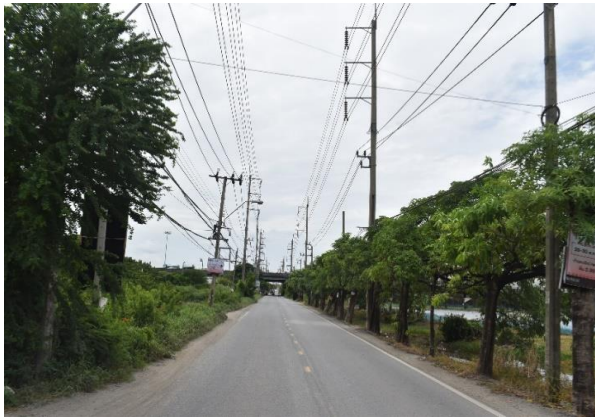
รูปก่อนการก่อสร้าง กม.ที่ ๓+๖๐๐
