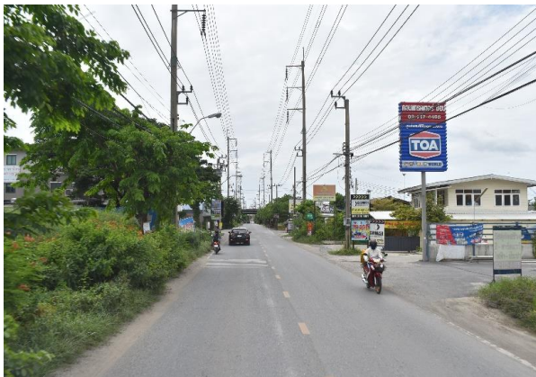
รูปก่อนการก่อสร้าง กม.ที่ ๓+๕๐๐
