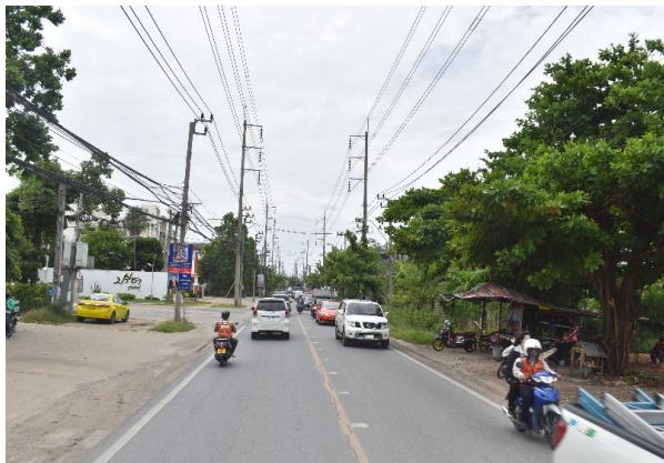
รูปก่อนการก่อสร้าง กม.ที่ ๑+๗๐๐
