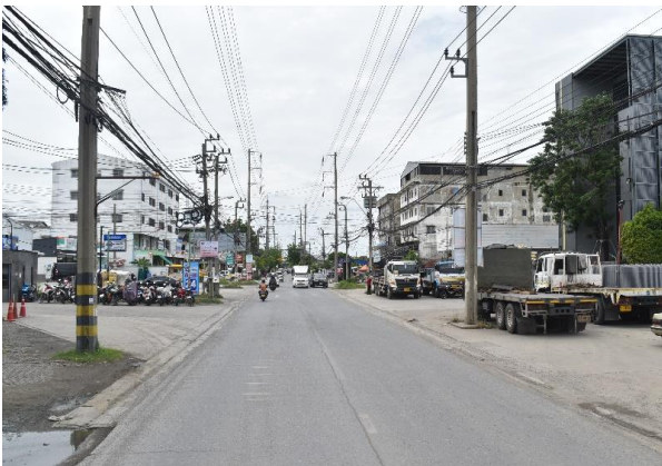
รูปก่อนการก่อสร้าง กม.ที่ ๑+๙๐๐
