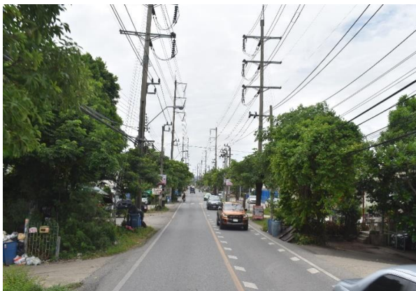
รูปก่อนการก่อสร้าง กม.ที่ ๒+๗๐๐
