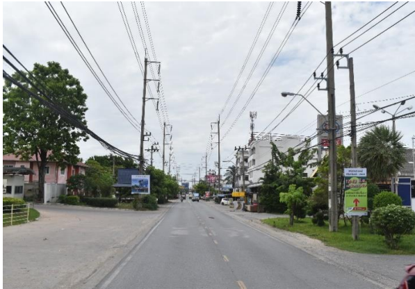
รูปก่อนการก่อสร้าง กม.ที่ ๐+๕๐๐
