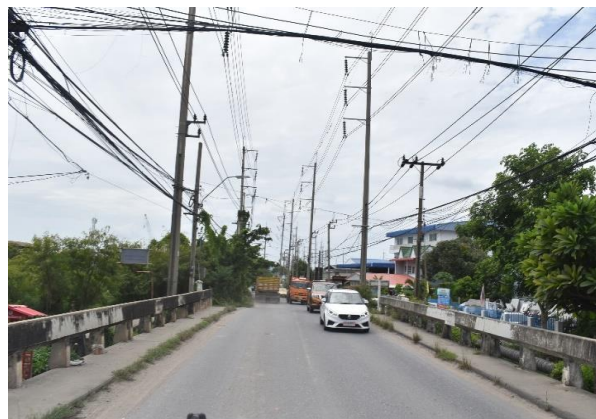
รูปก่อนการก่อสร้าง กม.ที่ ๔+๙๐๐
