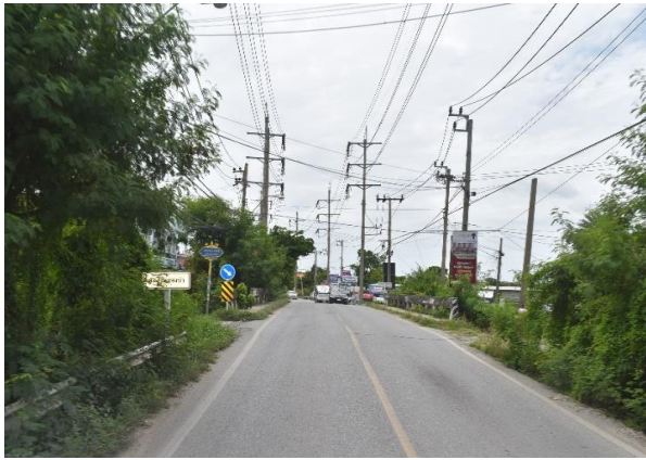
รูปก่อนการก่อสร้าง กม.ที่ ๔+๐๐๐
