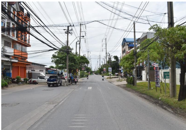
รูปก่อนการก่อสร้าง กม.ที่ ๓+๓๐๐
