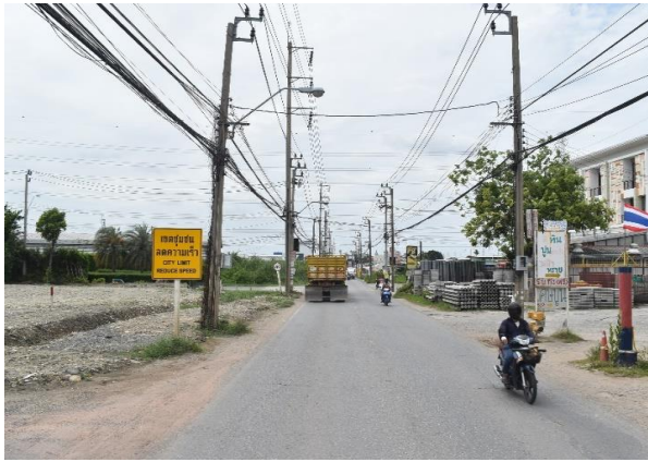
รูปก่อนการก่อสร้าง กม.ที่ ๖+๒๐๐
