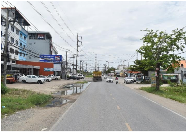
รูปก่อนการก่อสร้าง กม.ที่ ๖+๐๐๐
