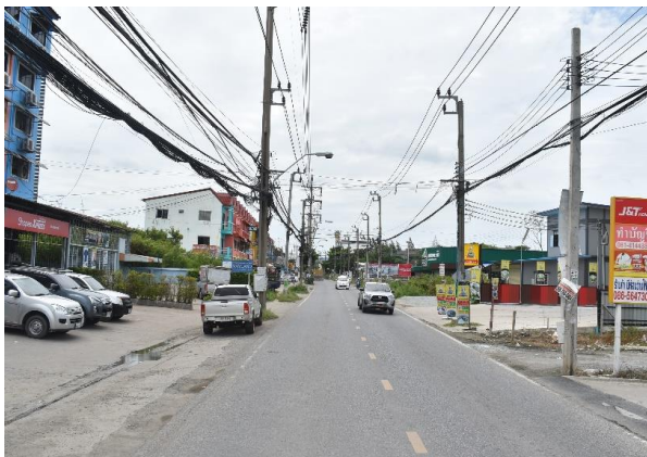
รูปก่อนการก่อสร้าง กม.ที่ ๖+๗๐๐
