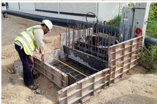
งานต่อปากบ่อพักชนิดฝาคอนกรีตสำหรับท่อขนาด 1.20 x 1.20 เมตร กม.ที่ 2+770—3+043 RT
