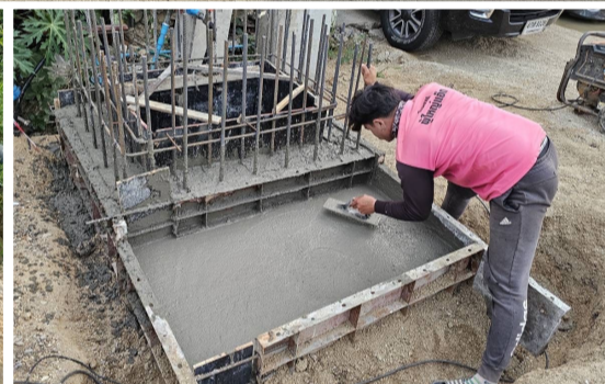
งานต่อปากบ่อพักชนิดฝาคอนกรีตสำหรับท่อขนาด 1.20 x 1.20 เมตร กม.ที่ 2+770—3+043 RT
