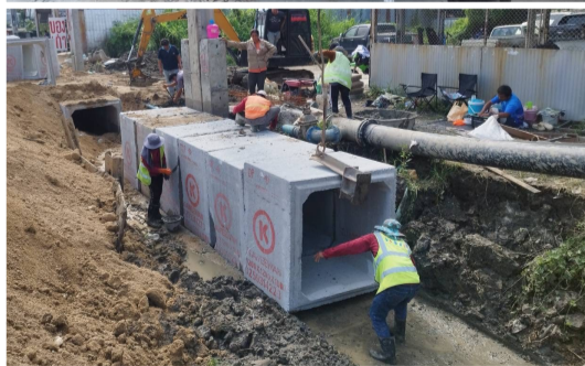
งานต่อเหลี่ยมคอนกรีตเสริมเหล็กขนาด 1 - 1.20 x 1.20 เมตร กม.ที่ 2+171 - กม.ที่ 2+201 LT และกม.ที่ 1+949 - กม.ที่ 1+995 RT
