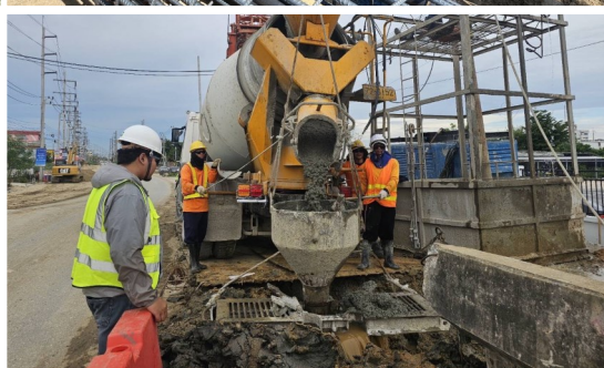
งานเสาเข็มเจาะหล่อในที่สำหรับเสาเข็มใช้งาน ขนาดเส้นผ่านศูนย์กลาง 0.80 ม. กม.ที่ 4+053.356 (สะพานข้ามคลองหนองบัว)
