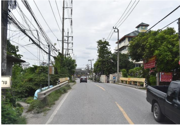
รูปก่อนการก่อสร้าง กม.ที่ ๘+๐๐๐
