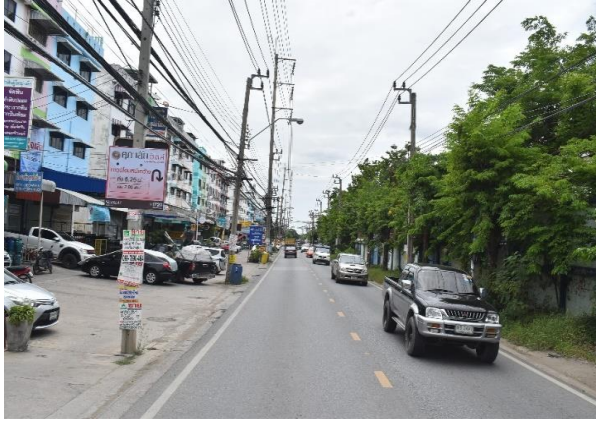
รูปก่อนการก่อสร้าง กม.ที่ ๗+๒๐๐
