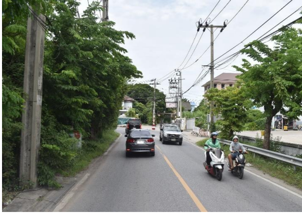
รูปก่อนการก่อสร้าง กม.ที่ ๗+๖๐๐
