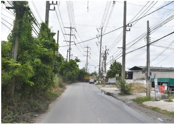
รูปก่อนการก่อสร้าง กม.ที่ ๕+๐๐๐
