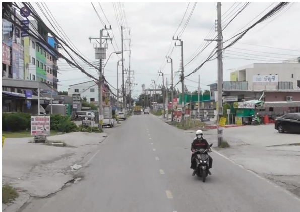
รูปก่อนการก่อสร้าง กม.ที่ ๖+๖๐๐
