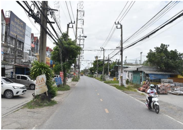
รูปก่อนการก่อสร้าง กม.ที่ ๖+๘๐๐
