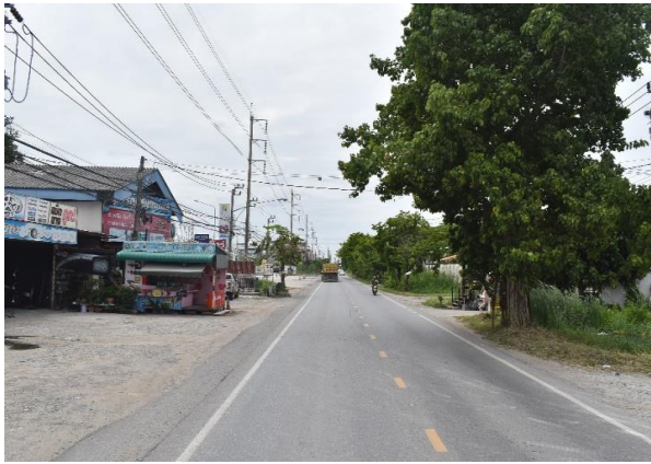
รูปก่อนการก่อสร้าง กม.ที่ ๕+๖๐๐
