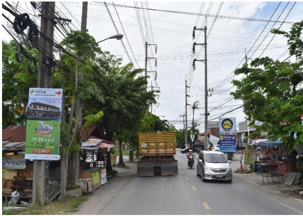
รูปก่อนการก่อสร้าง กม.ที่ ๕+๒๐๐
