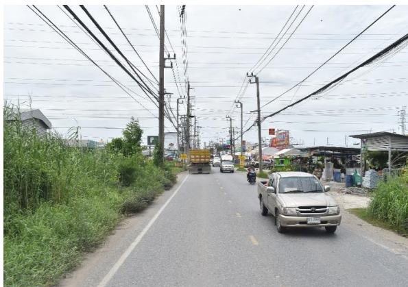
รูปก่อนการก่อสร้าง กม.ที่ ๖+๓๐๐
