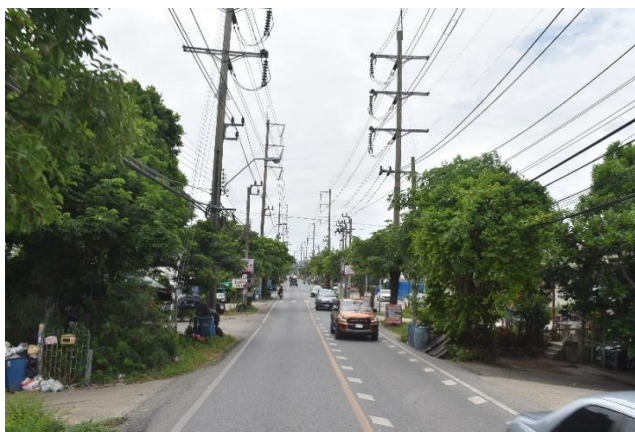
รูปก่อนการก่อสร้าง กม.ที่ ๒+๗๐๐
