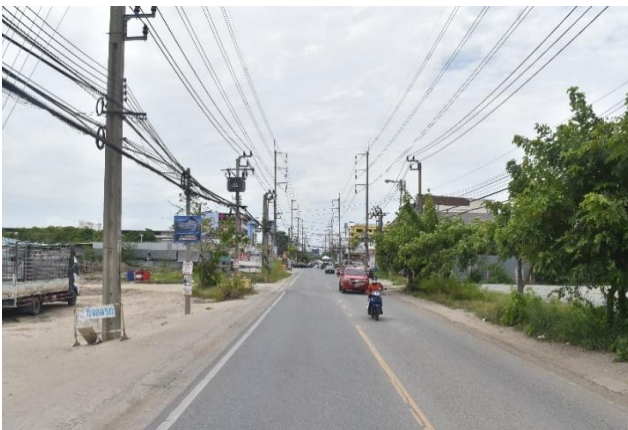
รูปก่อนการก่อสร้าง กม.ที่ ๐+๓๐๐
