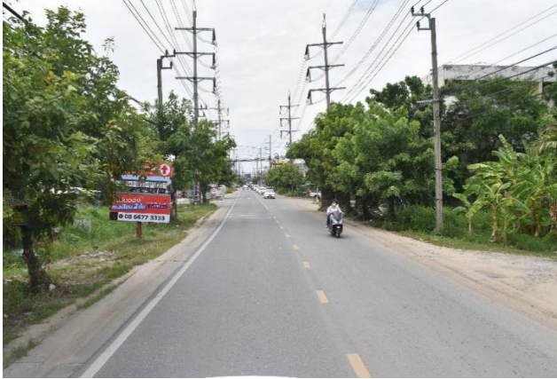
รูปก่อนการก่อสร้าง กม.ที่ ๐+๒๐๐
