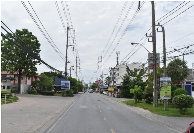
รูปก่อนการก่อสร้าง กม.ที่ ๐+๖๐๐
