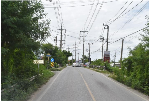
รูปก่อนการก่อสร้าง กม.ที่ ๔+๐๐๐
