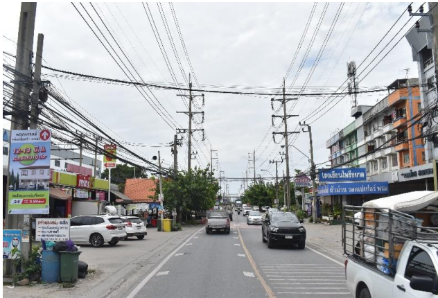
รูปก่อนการก่อสร้าง กม.ที่ ๑+๐๐๐
