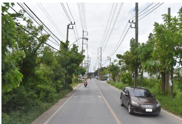
รูปก่อนการก่อสร้าง กม.ที่ ๒+๓๐๐
