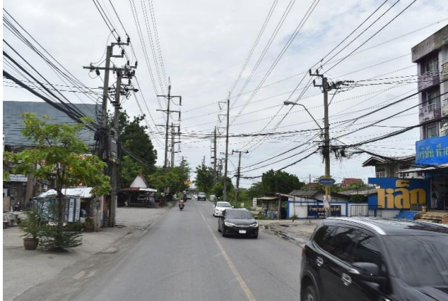
รูปก่อนการก่อสร้าง กม.ที่ ๒+๐๐๐
