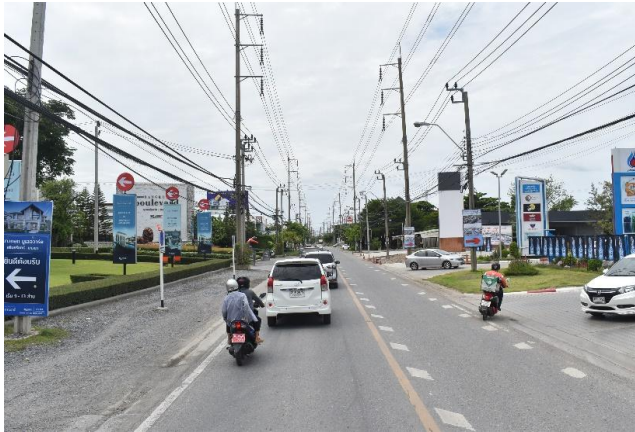
รูปก่อนการก่อสร้าง กม.ที่ ๑+๔๐๐
