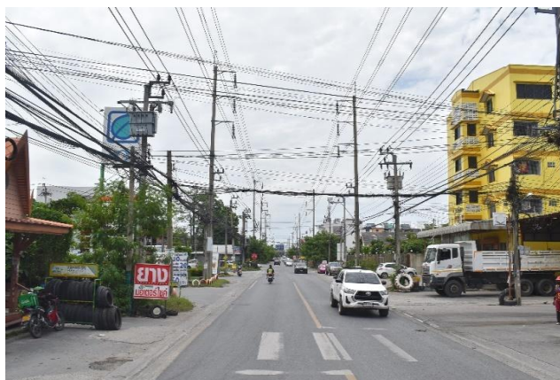
รูปก่อนการก่อสร้าง กม.ที่ ๐+๕๐๐
