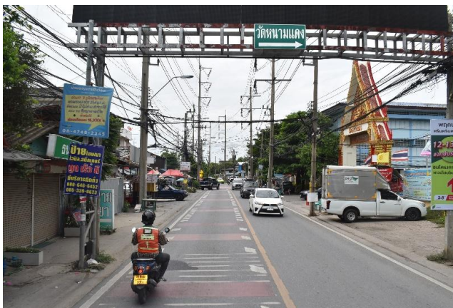
รูปก่อนการก่อสร้าง กม.ที่ ๒+๕๐๐
