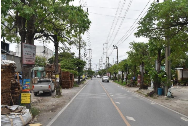
รูปก่อนการก่อสร้าง กม.ที่ ๒+๘๐๐
