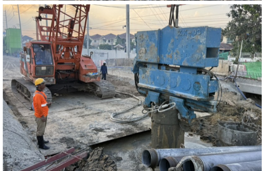
งานเสาเข็มเจาะหล่อในที่สำหรับเสาเข็มใช้งาน ขนาดเส้นผ่านศูนย์กลาง 0.80 ม. กม.ที่ 7+035.888 (สะพานคลองใหม่) และกม.ที่ 7+988.722 (สะพานคลองเสื่อต่าย)
