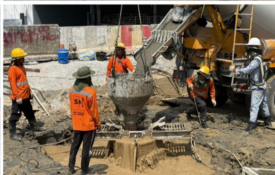
งานเสาเข็มเจาะหล่อในที่สำหรับเสาเข็มใช้งาน ขนาดเส้นผ่านศูนย์กลาง 0.80 ม. กม.ที่ 7+035.888 (สะพานคลองใหม่) และกม.ที่ 7+988.722 (สะพานคลองเสื่อต่าย)
