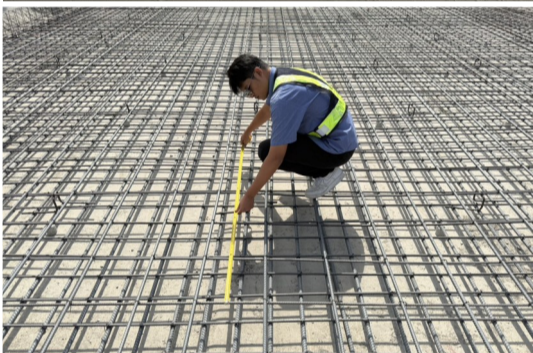
งานพื้นคอนกรีตปรับระดับช่วงเข้าสู่สะพาน (BRIDGE APPROACH SLAB) กม.ที่ 0+115.378 (สะพานคลองกระทุ่ม) กม.ที่ 0+828.364 (สะพานคลองหนามแดงเดชะ) และกม.ที่ 2+692.197 (สะพานคลองหลวงแพ่ง)
