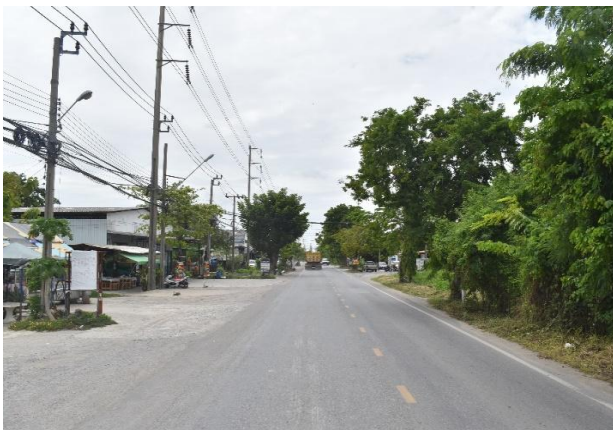
รูปก่อนการก่อสร้าง กม.ที่ ๕+๕๐๐
