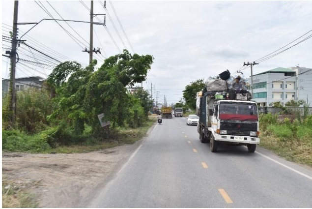
รูปก่อนการก่อสร้าง กม.ที่ ๕+๘๐๐
