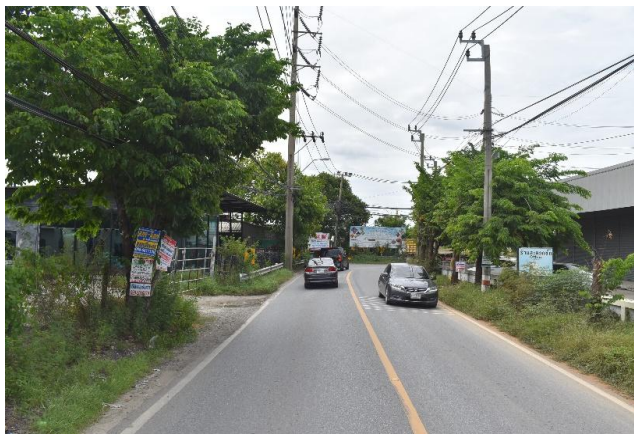
รูปก่อนการก่อสร้าง กม.ที่ ๗+๕๐๐
