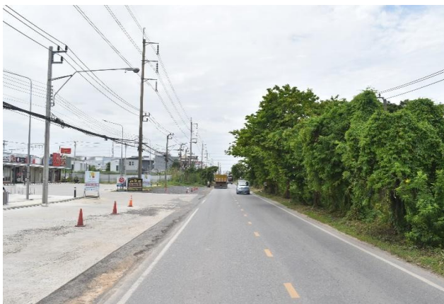
รูปก่อนการก่อสร้าง กม.ที่ ๕+๗๐๐
