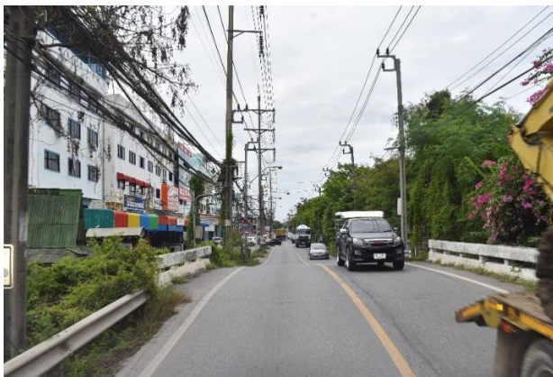
รูปก่อนการก่อสร้าง กม.ที่ ๗+๑๐๐
