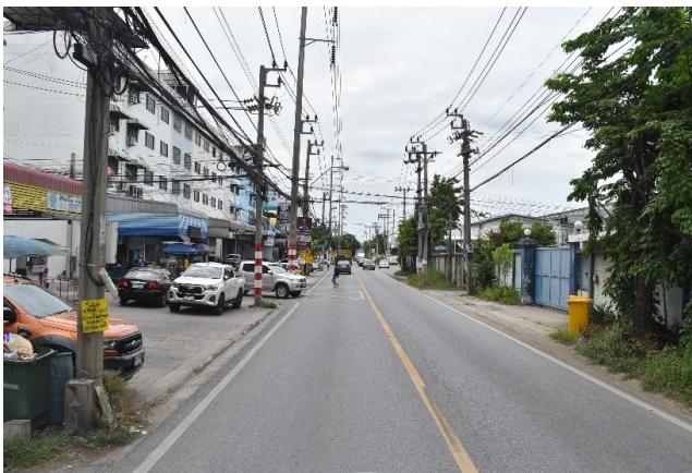
รูปก่อนการก่อสร้าง กม.ที่ ๗+๓๐๐
