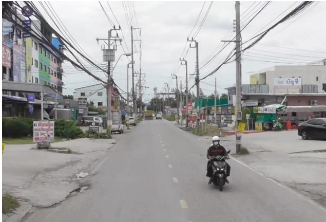
รูปก่อนการก่อสร้าง กม.ที่ ๖+๖๐๐
