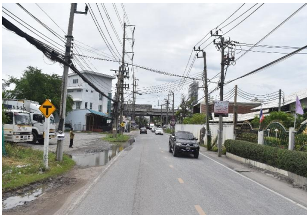
รูปก่อนการก่อสร้าง กม.ที่ ๘+๑๐๐
