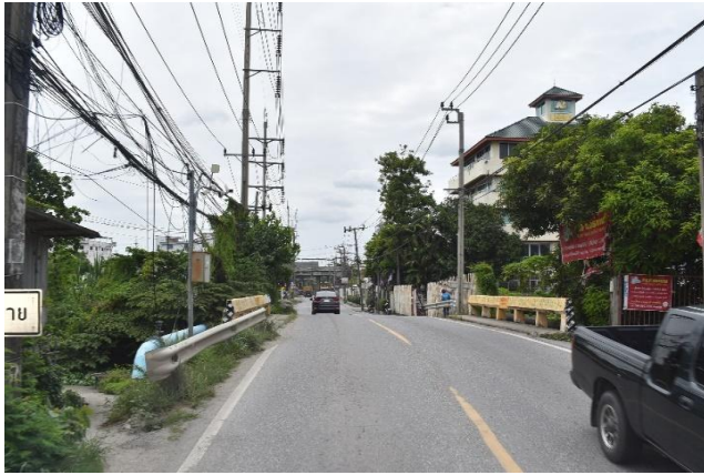
รูปก่อนการก่อสร้าง กม.ที่ ๘+๐๐๐
