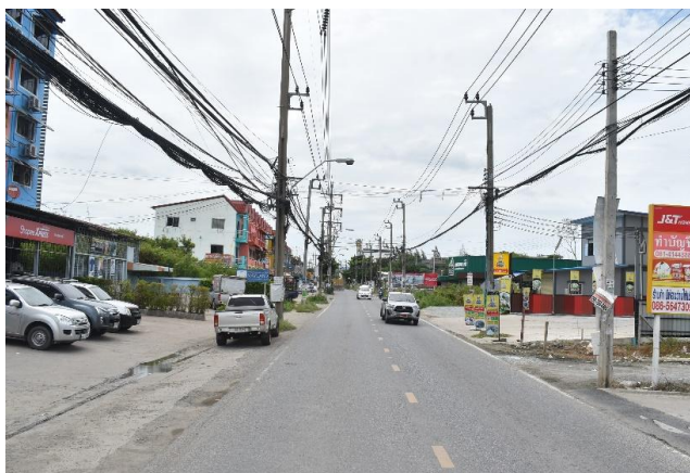
รูปก่อนการก่อสร้าง กม.ที่ ๖+๗๐๐
