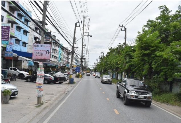
รูปก่อนการก่อสร้าง กม.ที่ ๗+๒๐๐
