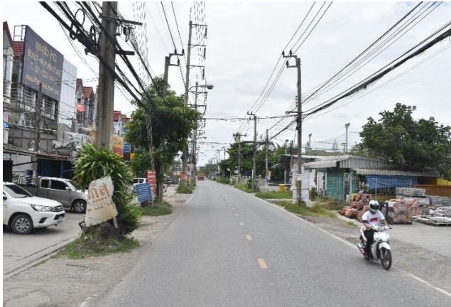
รูปก่อนการก่อสร้าง กม.ที่ ๖+๘๐๐
