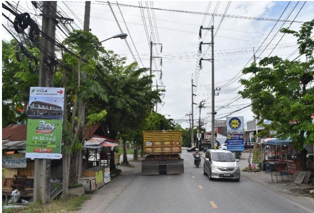
รูปก่อนการก่อสร้าง กม.ที่ ๕+๒๐๐
